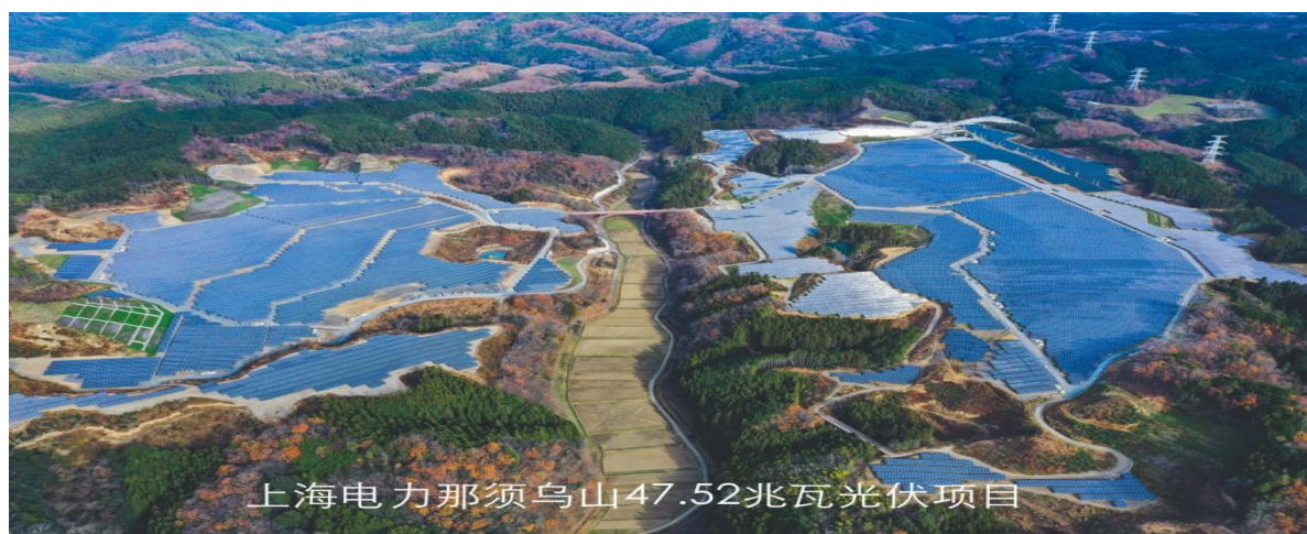
上海电力那须乌山光伏项目
